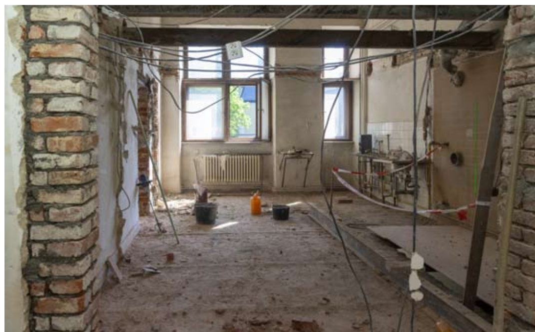
Bývalá přírodovědná laboratoř v prvním patře se proměňuje na toalety a výtah (2018)
