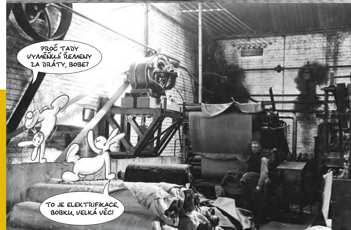
Nahoře i dole: Nová rozvodná deska a první elektromotory těsně po začátku 20. století v Preibischově továrně v Dětrichově
