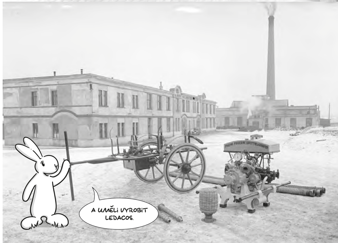
Nahoře: Nýtovaný kotel, výrobek firmy Linser | Dole: Bývalá továrna RAF, od roku 1926 provozovaná firmou Ch. Linser
