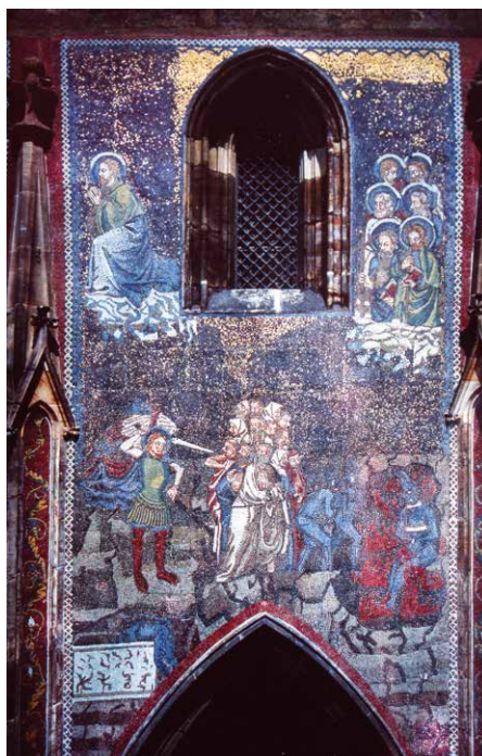
Pravý díl mozaiky po vyčištění od koroze
