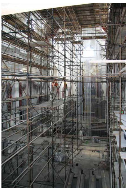
Pohled do kostela během prací
