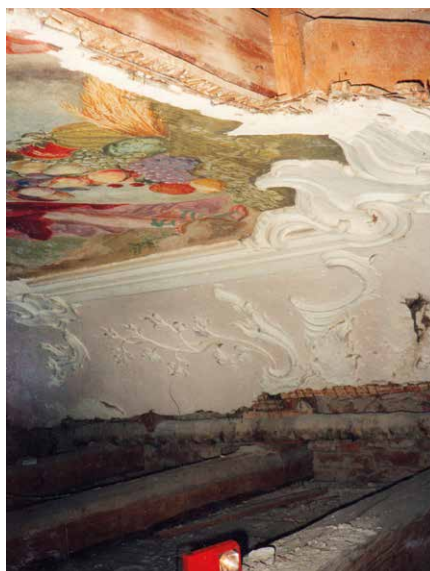
Pohled do mezistropního prostoru
