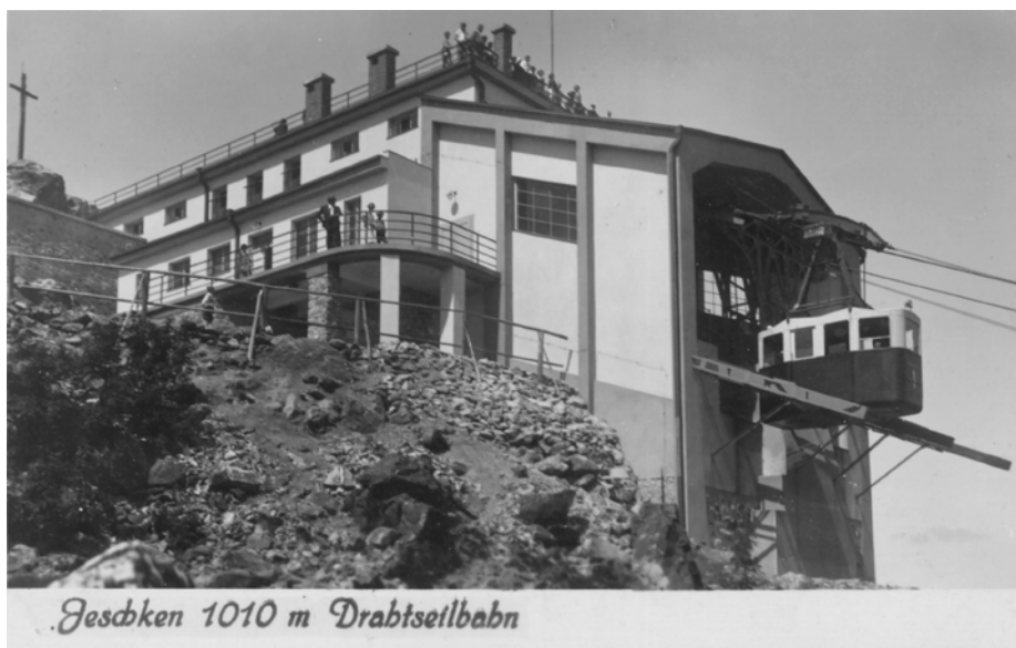
Horní stanice nedlouho po dokončení
