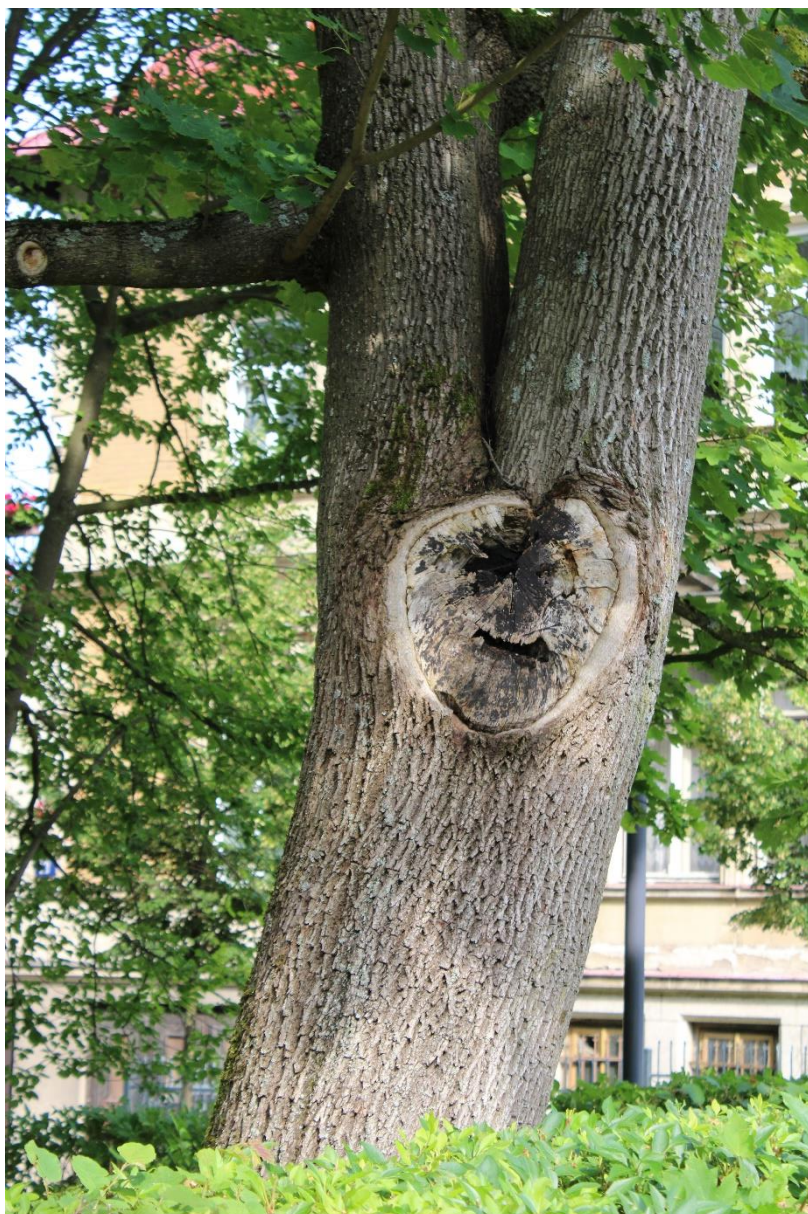
Rozpadající se tlakové větvení s hnilobou u javoru mléče ( Acer platanoides ) č. 46 navrženého ke kácení.
