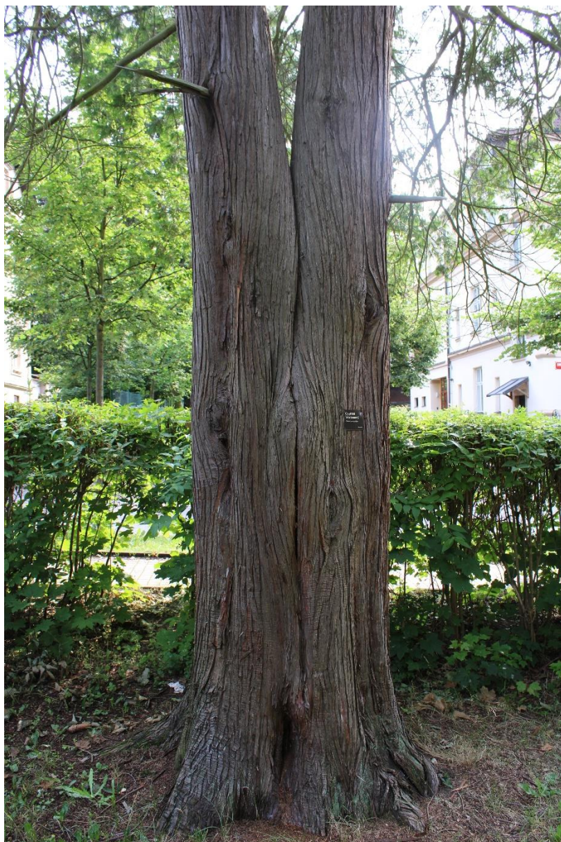
Detail kmene Chamaecyparis pisifera č. 11 s dutinou v bázi kmene a tlakovým větvením, jedinec je proschlý. Krátkodobé zachování jedince je možné při instalaci vazeb do koruny.
