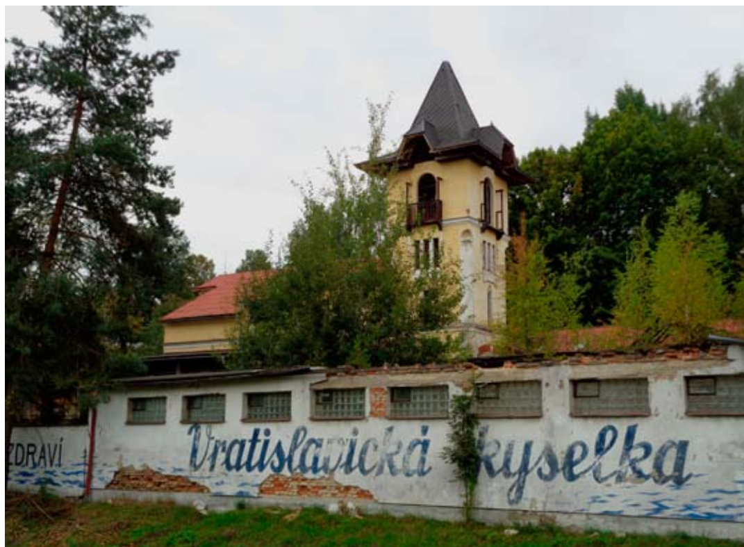
NAHOŘE: Současný stav bývalého lázeňského areálu ve Vratislavicích nad Nisou (foto L. Lacina)
